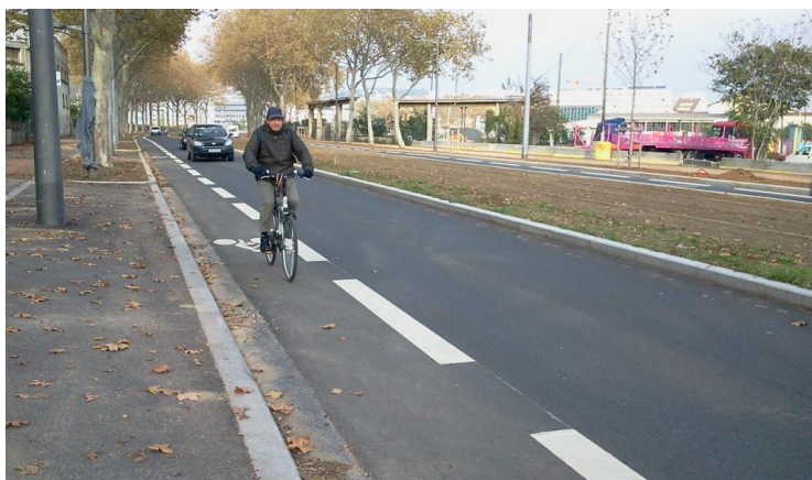
Figure 7 : la bande est en continuité avec la chaussée pour voitures, sans dénivellation ni bordure, mais bien visible grâce aux tracés peints et bien entretenus.
