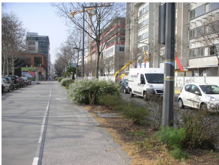
Figure 6 : Si la piste cyclable est bien séparée de la chaussée, elle ne l'est pas bien du trottoir.
