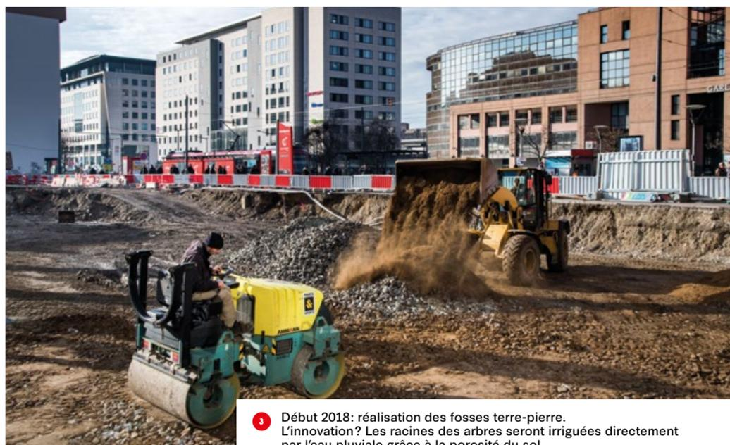
3 Début 2018: réalisation des fosses terre-pierre. L'innovation? Les racines des arbres seront irriguées directement par l'eau pluviale grâce à la porosité du sol.
