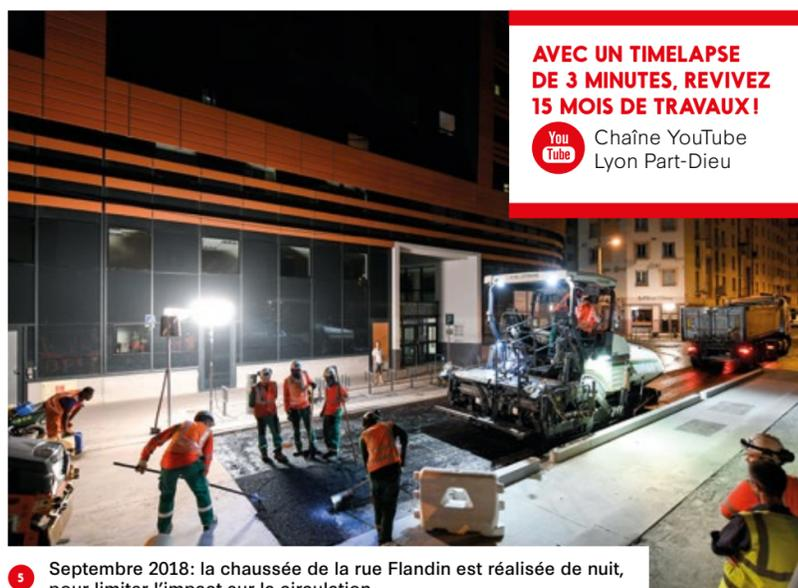
5 Septembre 2018: la chaussée de la rue Flandin est réalisée de nuit, pour limiter l'impact sur la circulation.
