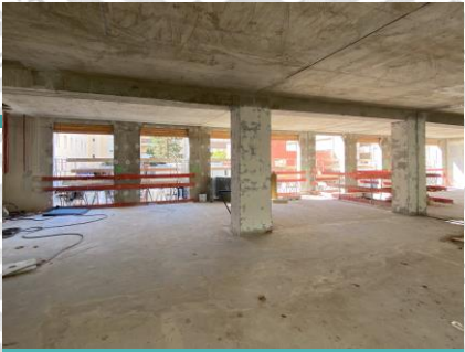
PRIMATVERA – rénovation en cours
