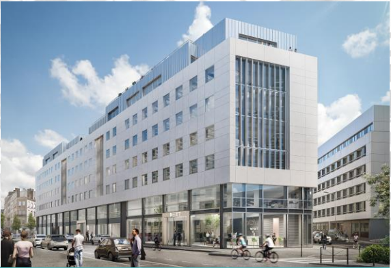
NEXT (rénovation en cours)
