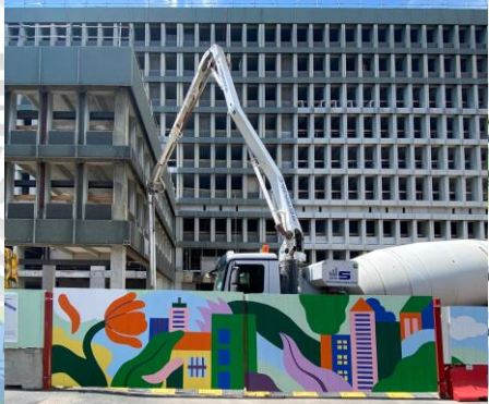
AUDESSA – Rénovation en cours
