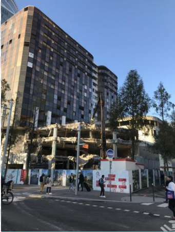
KI (démolition en cours)
