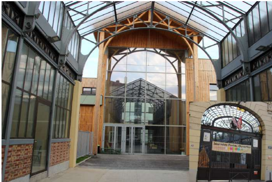
P orte d'entrée et v errière.
