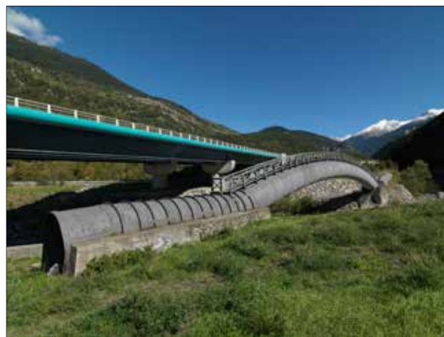
Conduite forcée de l'usine d'électro-chimie, Thierry Leroy © Région Auvergne-Rhône-Alpes, Inventaire général du patrimoine culturel ; 2015- A.D.A.G.P.
