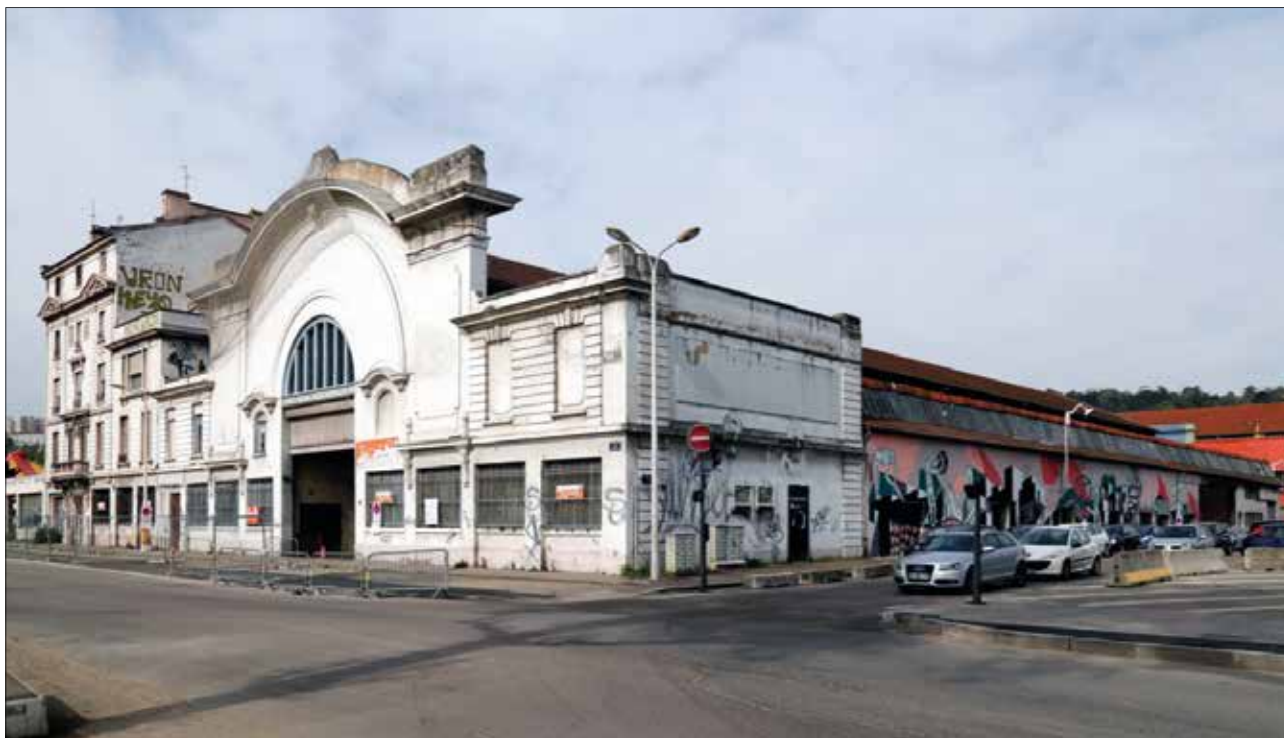
Façade de la Halle Girard avant travaux © VURPAS ARCHITECTES
