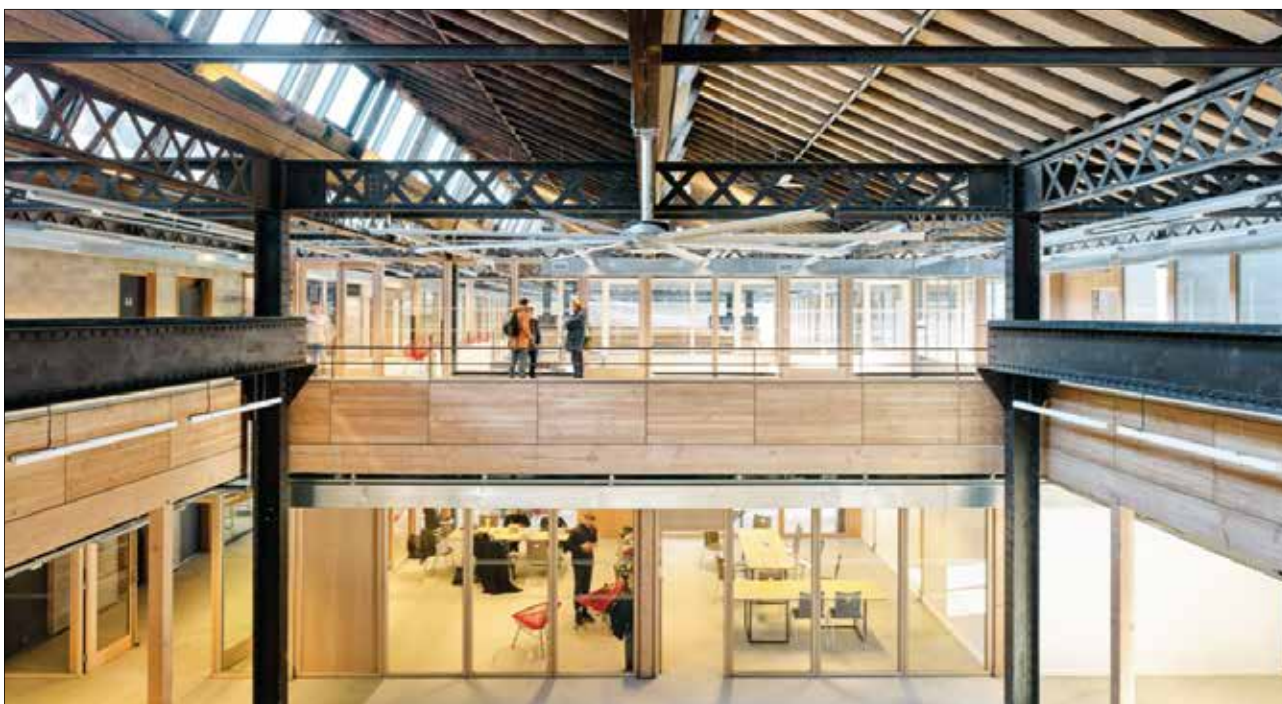
Intérieur de la Halle, charpente métallique d'origine, charpente en bois et espaces de bureaux en mezzanine © Kevin Dolmaire
