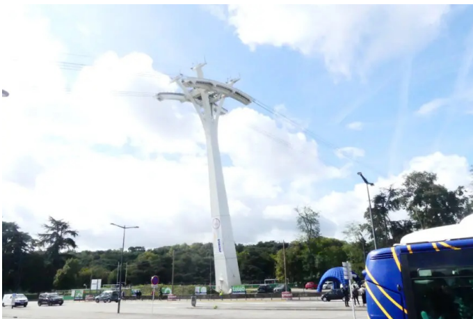
Ce pylône fait 47 mètres de haut. Le plus haut fait 70 mètres de haut.
